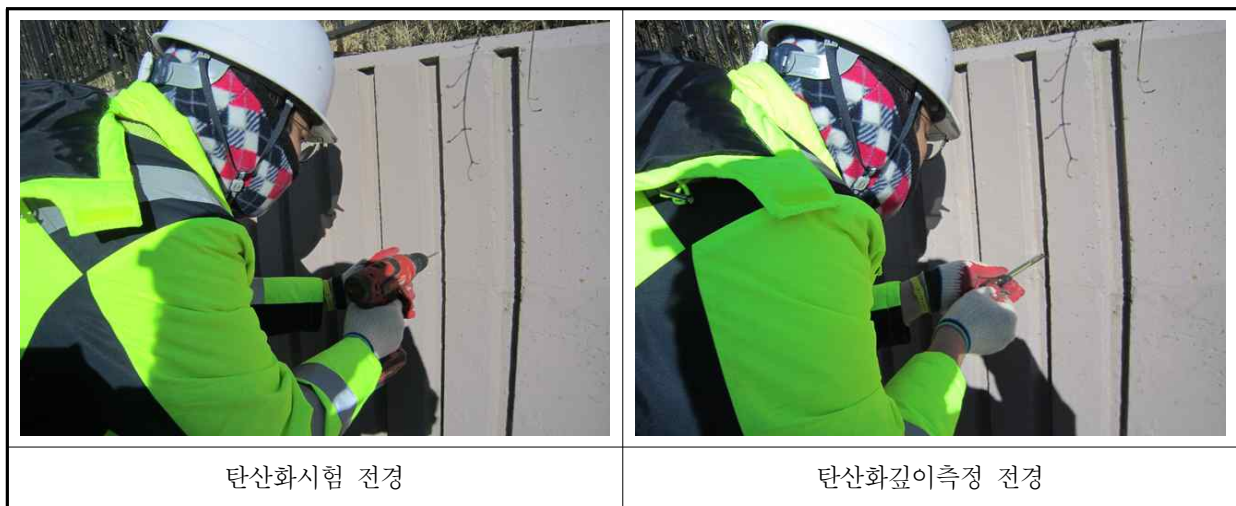
【표 3.34】 탄산화깊이측정 결과
