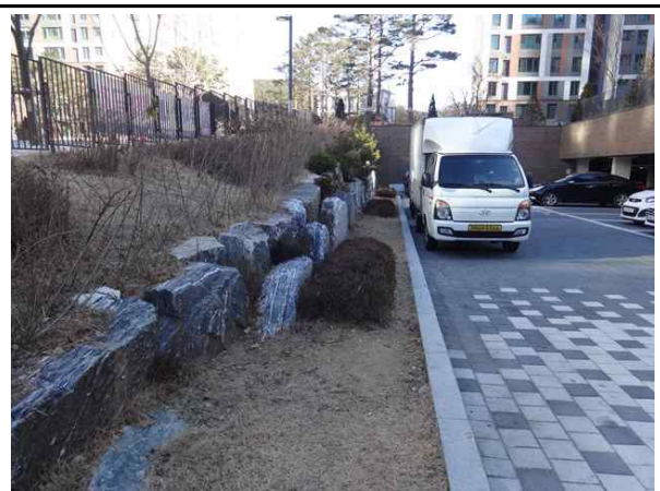
7호 L형 옹벽 전경
