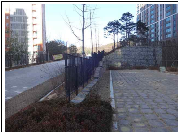
6호 L형 옹벽 전경
