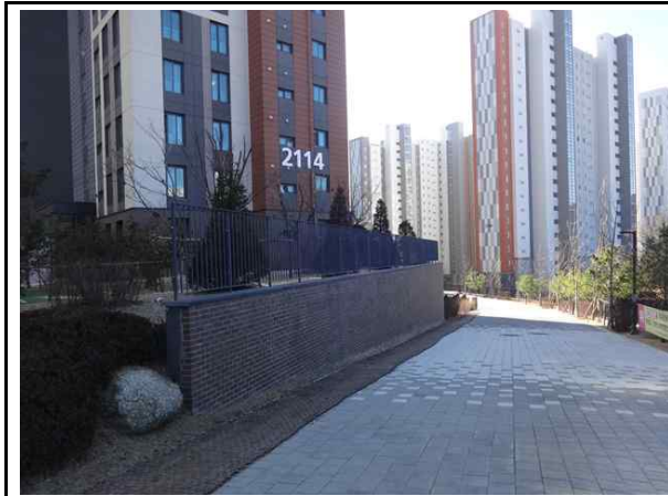
10호 L형 옹벽 전경
