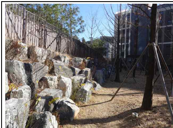
10호 L형 옹벽 전경
